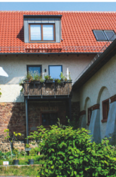
Bestandsgelände mit vorgesetzten Balkonen
