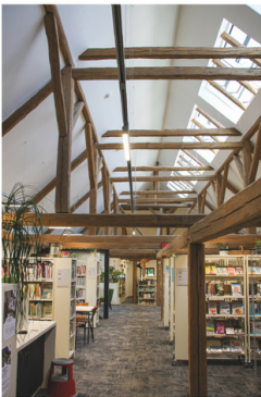
Stadtbibliothek mit freigelegtem historischem Dachstuhl
