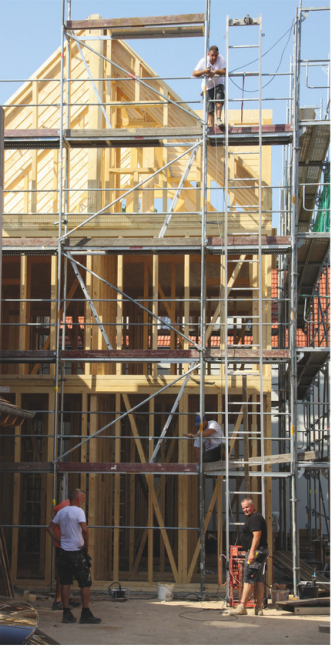
ZukunftsRaum 2: Sanierung eines ehemaligen Weinguts mit Neubau zur Nachverdichtung
