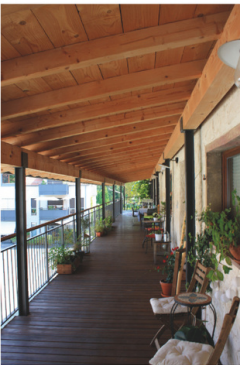
Laubengang zur Erschließung der Wohnungen im ersten Obergeschoss
