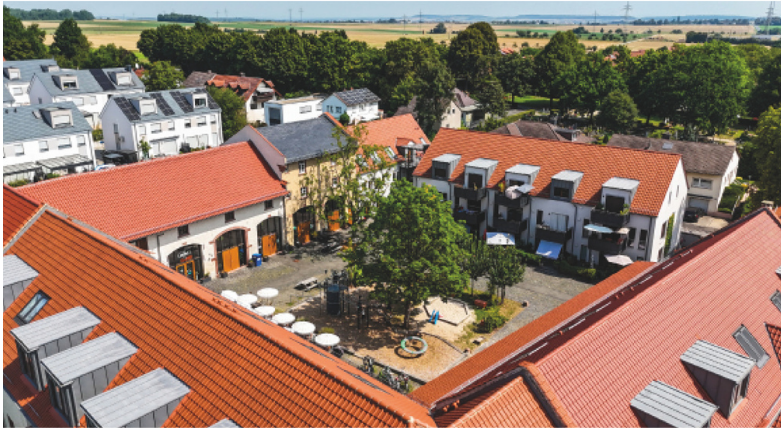
Luftbild vom umschlossenen Innenhof des denkmalgeschützten Hofes
