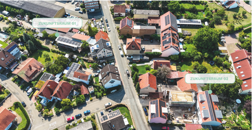
Luftbild der ersten Realisierung vom ZukunftsRaum 01 und ZukunftsRaum 02 während der Umbauphase
